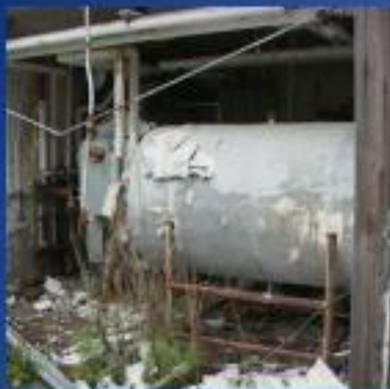
آزبست در دیگ بخار عایق شده
